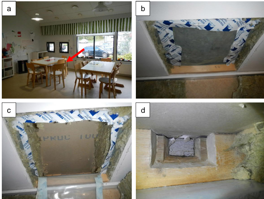
Kuvat 13a-d. Rakenneavaus RAK4 sijaitsi tilassa 44 RH1. Rakenneavauksessa ei havaittu vauriojälkiä. Poikkeavaa hajua ei havaittu. Alajuoksupuun alapinta oli siisti. Alajuoksupuuta on kaksi päällekkäin, alempi on painekyllästettyä puuta.
