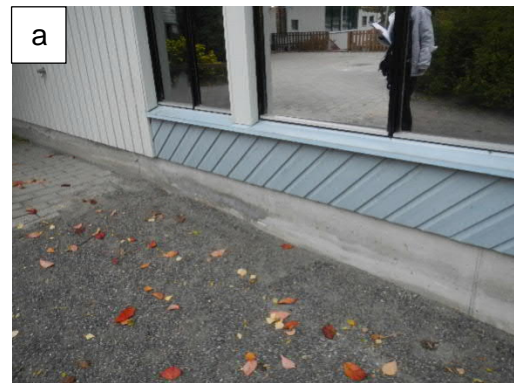
Kuvat 4a ja b. Lounaisjulkisivulla on sokkelin vierellä betonikiveystä sekä soraa ja hienojakoista maa-ainesta. Sokkelin pinnalla on kalkkihärmettä.
