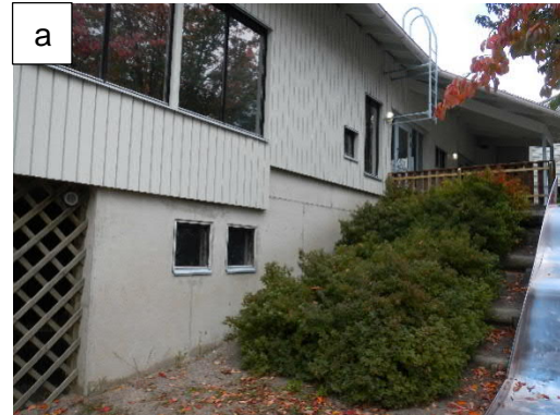
Kuvat 3a ja b. Kaakkoisjulkisivulla alustatilan pohjalla ja sen ulkopuolella on hiekkaa. Alustatilassa on leikkipaikka. Kaakkoissivulla maa nousee kohti sisäänkäyntiä. Seinän vierustalla on kasvillisuutta.
