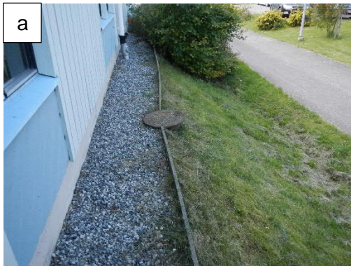
Kuvat 2a ja b. Luoteissivulla maa kallistaa rakennuksesta poispäin (kuva a). Alustatallisella osiolla lounaispäädyssä on nurmea sokkelin vierellä.
