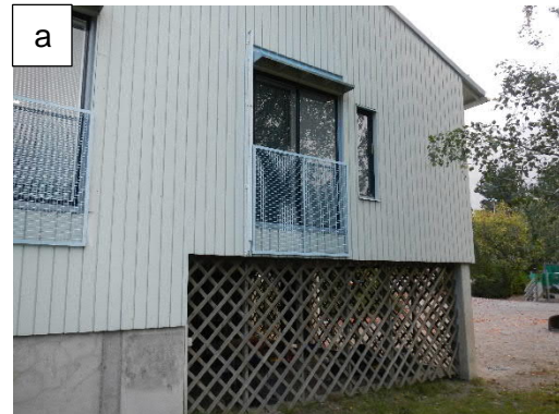
Kuvat 2a ja b. Luoteissivulla maa kallistaa rakennuksesta poispäin (kuva a). Alustatallisella osiolla lounaispäädyssä on nurmea sokkelin vierellä.
