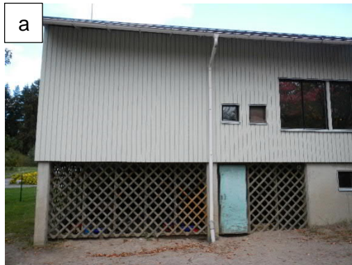
Kuvat 3a ja b. Kaakkoisjulkisivulla alustatilan pohjalla ja sen ulkopuolella on hiekkaa. Alustatilassa on leikkipaikka. Kaakkoissivulla maa nousee kohti sisäänkäyntiä. Seinän vierustalla on kasvillisuutta.
