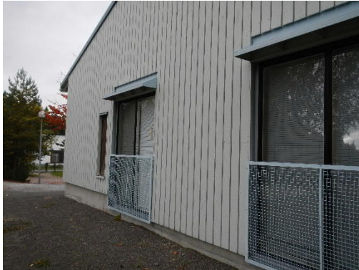
Kuva 6. Kaakkoispäädyssä on sokkelin vierellä sora. Sokkeli on päädyssä melko matala.
