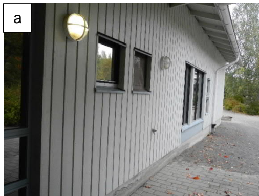
Kuvat 4a ja b. Lounaisjulkisivulla on sokkelin vierellä betonikiveystä sekä soraa ja hienojakoista maa-ainesta. Sokkelin pinnalla on kalkkihärmettä.
