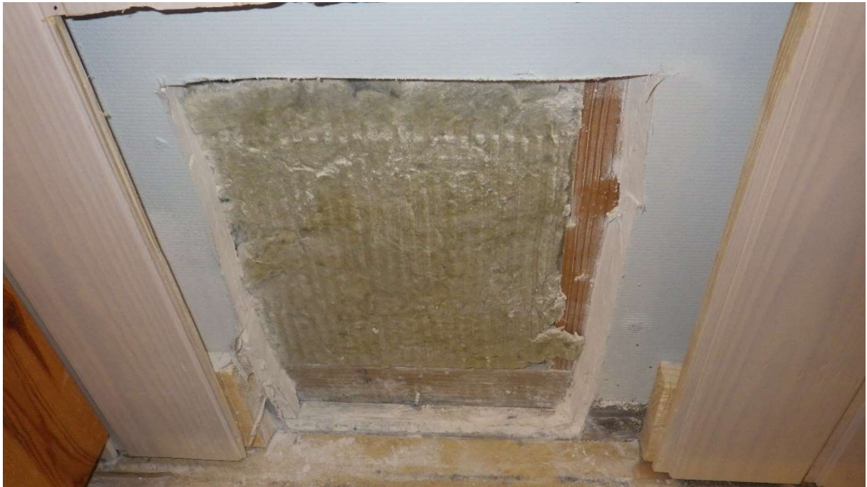
Kuva 66. Liikuntasalin ja VEO huoneen väliseinän rakenneavaus VSAV2.
