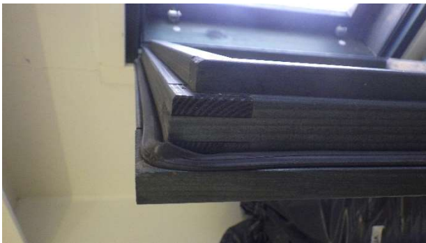
Kuva 53. Saumanauhat ovat painuneita. Niitä on uusittu vaihtelevasti.
