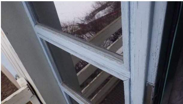
Kuva 55. Sisäänkäynnin puulistoissa oli alkavaa haristumista.
