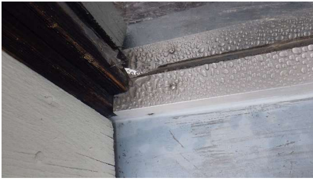
Kuva 57. Ikkunoiden kittisaumoissa oli puutteita.
