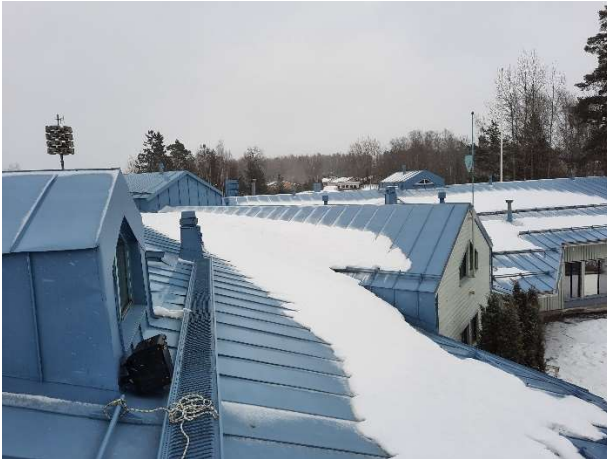
Kuva 81. Yleiskuva vesikatolta. Tarkastushetkellä katolla oli paikoin lumipeitettä.
