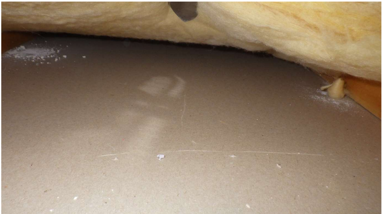
Kuva 73. Avauksen vierellä villojen alla ei havaittu merkkejä epätavallisesta kosteudesta.
