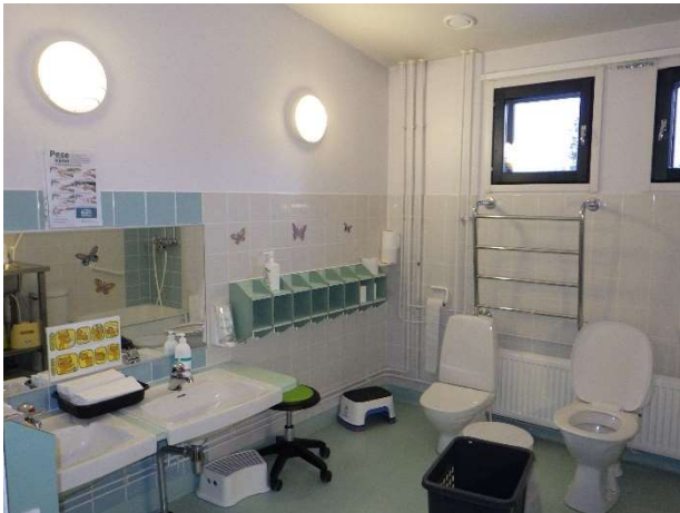
Kuva 27. Yleiskuvaa märkätiloista. Lattiat pinnat ovat muovimattoja ja seinien alaosat kaakeloituja.
