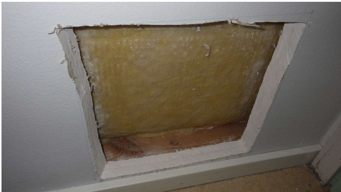
Kuva 63. Johtajan huoneen väliseinään tehty rakenneavaus VSAV1
