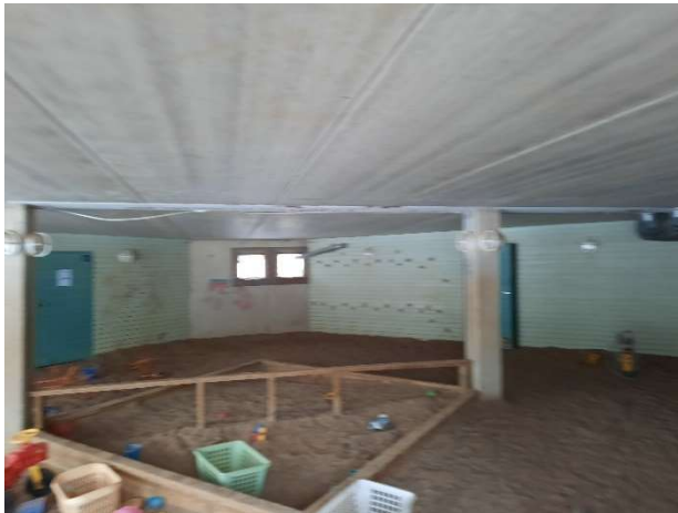
Kuva 9. Rakennuksen lounaissiiven alapuolista tilaa.
