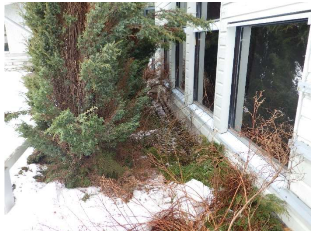
Kuva 8. Sisäpihalla liikuntasalin edustalla istutukset ovat erittäin lähellä rakennusta.
