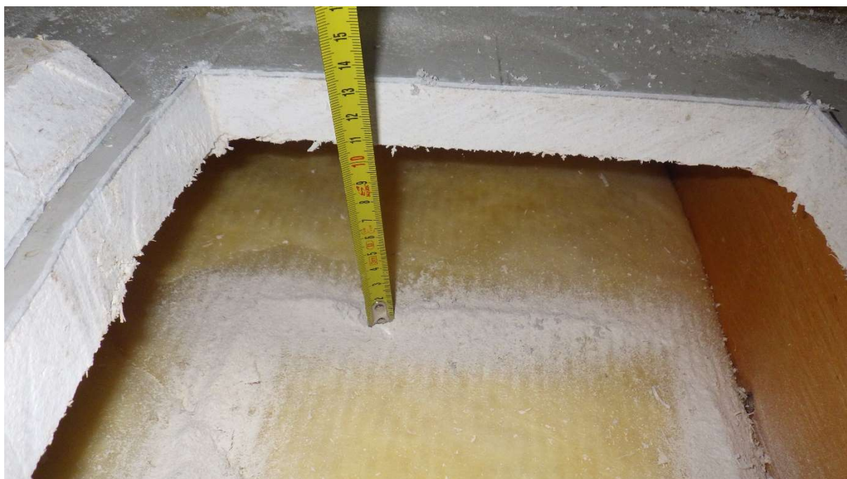
Kuva 71. Välipohjarakenteen rakenneavaus
