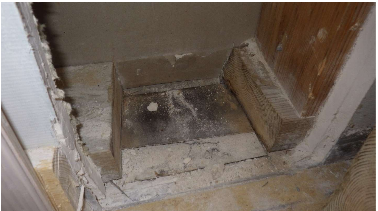
Kuva 67. Alaohjauspuun alla kaista haurasta bitumihuopaa VSAV2.
