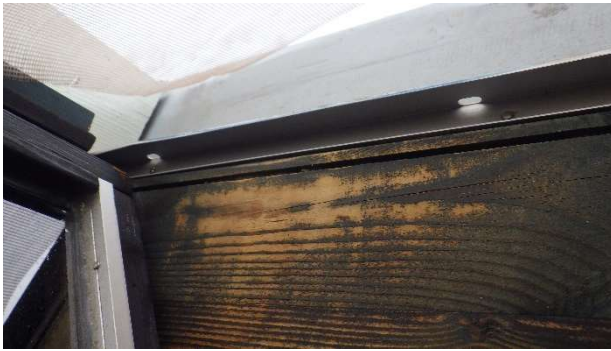
Kuva 51. Pinnoitteet ovat kuluneet etenkin etelänsuuntaan antavien ikkunoiden osalta.
