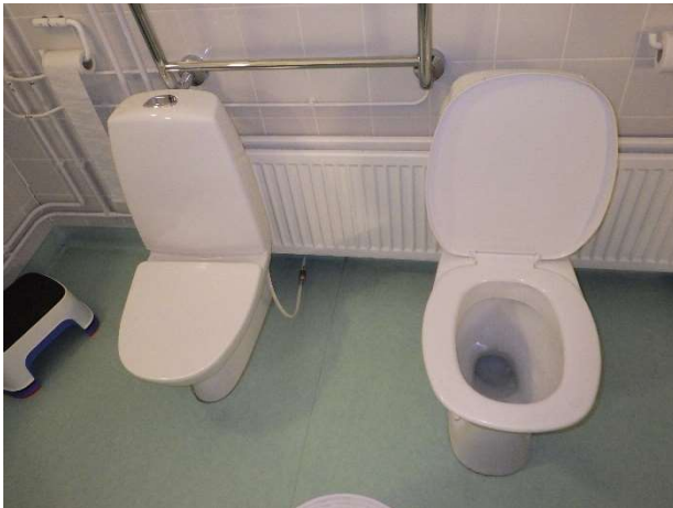
Kuva 29. WC-istuimissa ei havaittu merkittäviä puutteita.
