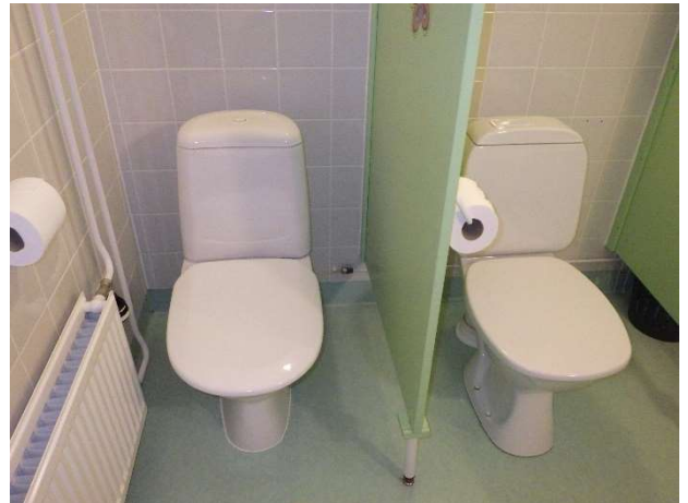
Kuva 28. WC-istuimia on vaihdettu tarpeen mukaan.
