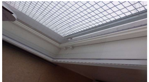
Kuva 54. Uusitut korkeat ikkunat/ovet ovat hyvässä kunnossa.
