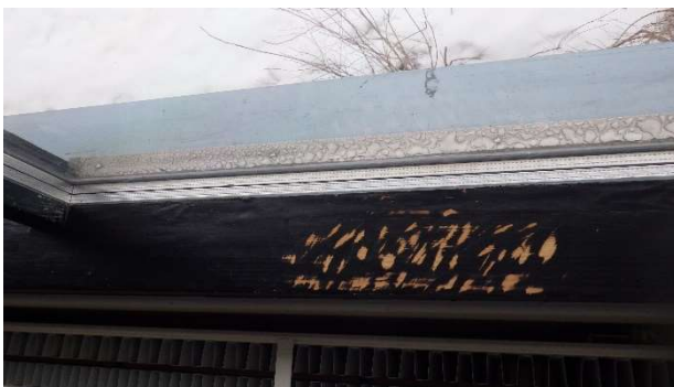
Kuva 49. Umpiolasielementtien yhteydessä ei havaittu lahoa tai merkittäviä vuotoja.
