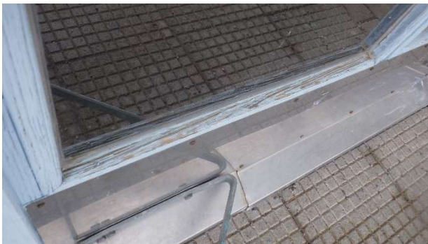
Kuva 57. Ikkunoiden kittisaumoissa oli puutteita.
