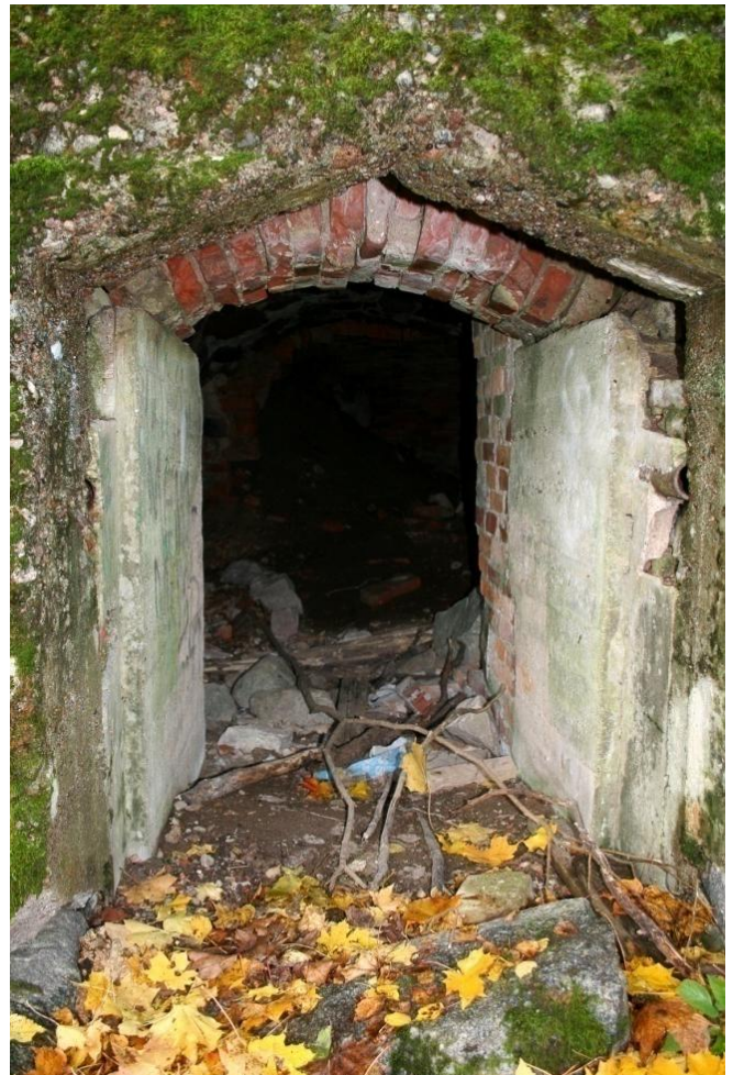
Kuva 27. Holvatus tiilikellarin suuosa on rapattu. Kellaritila noin 10 m levyinen. Kuva: Satu Koivisto/MV (AKDG2878:6).
