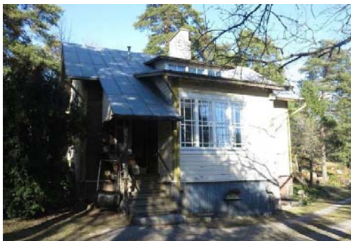
Kuva 11: 3004 Krönet. 1910-luvulla rakennettu satulakattoinen, hyvin ilmeensä säilyttänyt asuinrakennus, entinen rukoushuone. Kokonaisuuteen liittyy viereinen Karmelin rukoushuone ja puutarhamainen pihapiiri. Arkkitehtitoimisto Kristina Karlsson.
