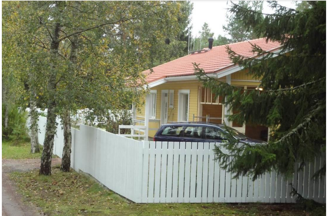
Kuva: Seurakuntayhtymän alueella sijaitseva isännöitsijän asuinrakennus (AO).
