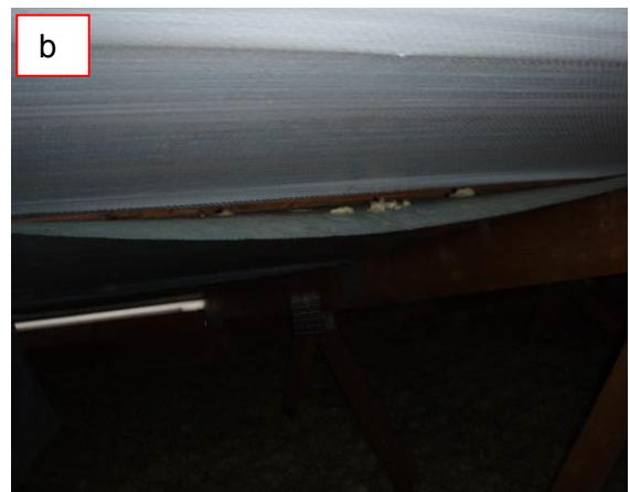
Kuva 51. Paikoin aluskatteen limitys on pieni ja limityskohta roikkuu. Roikkuvien aluskatteiden reunoissa ei havaittu valumajälkiä, jotka viittaisivat aluskatteen yläpuolelle tiivistyneen kosteuden valumisesta yläpohjan ilmatilaan.
