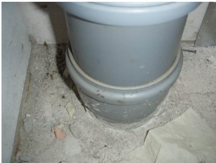
Kuva 8. Lasten wc-tilojen koteloinneissa olevien viemärien tuuletusputket ovat alapohjan betonilaatan valussa ja läpiviennit ovat aistinvaraisesti tiiviit.
