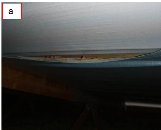
Kuva 51. Paikoin aluskatteen limitys on pieni ja limityskohta roikkuu. Roikkuvien aluskatteiden reunoissa ei havaittu valumajälkiä, jotka viittaisivat aluskatteen yläpuolelle tiivistyneen kosteuden valumisesta yläpohjan ilmatilaan.
